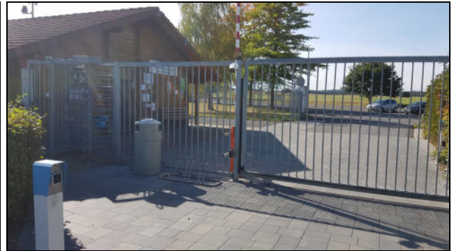
Abb. 4 Eingangsbereich mit Verwaltung
